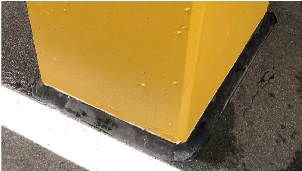
Bilde 18. Søyle i et parkeringshus. Reparert og gitt en gummitetning ned mot underlaget. (Foto: Mecamo Consulting AS)
