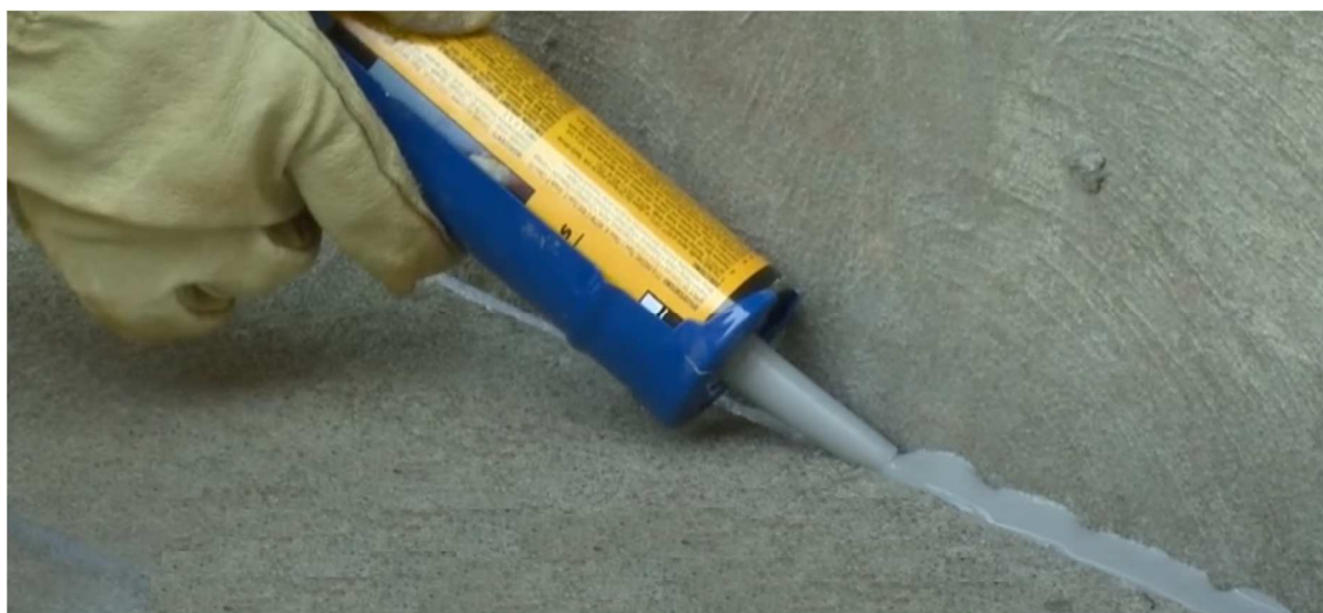
Bilde 14. Forsegling av ekspansjonsfuger.
