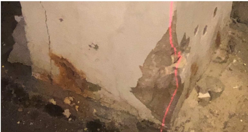
Figur 4. Uttak av støv for klorid-inntrengning i betongmassen.
