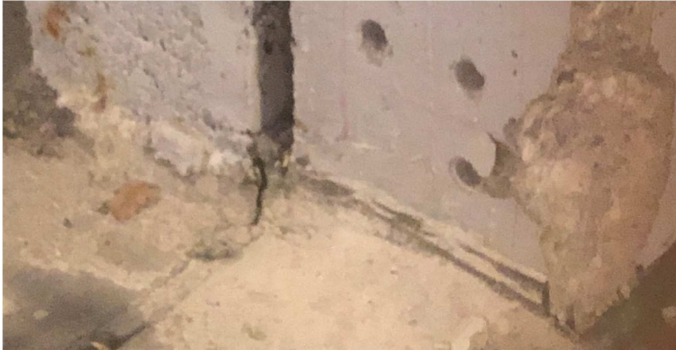
Figur 3. Uttak av støv for klorid-inntrengning i betongmassen.
